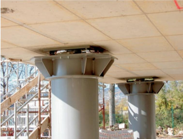
Figura 5 – Isolatore sismico.
