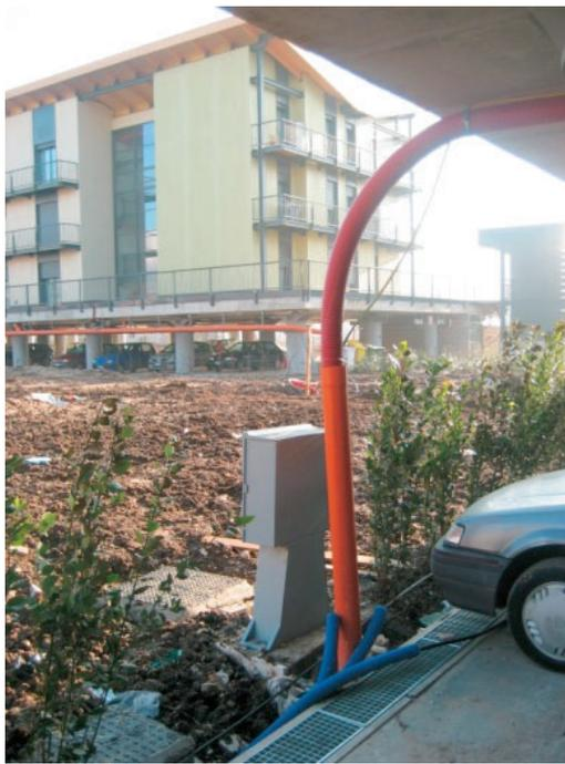
*Figura 17 – Cavidotto Enel e contenitore.*
