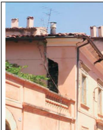
*Fig. 9 – Grave lesione ed innesco di crollo determinato dalla presenza della canna fumaria in breccia.*
