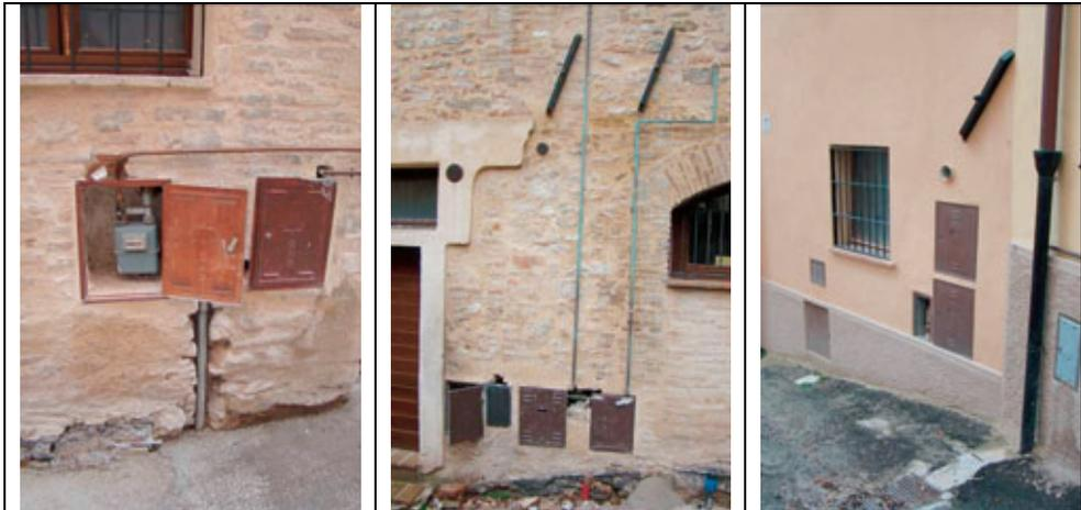
*Fig. 11 – Esempi di profonde incisioni e conseguenti indebolimenti dei maschi murari di edifici in muratura sottoposti a interventi di miglioramento sismico.*
