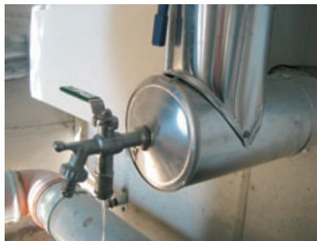
*Figura 14 – Dispositivo con elemento termostatico.*
