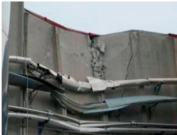
*Figura 9 - Potenziali criticità associate all'interazione con altri elementi. Schiacciamento delle condutture impiantistiche per effetto di martellamento dell'involucro di un silos contro la parete perimetrale. Terremoto de L'Aquila 2009.*
