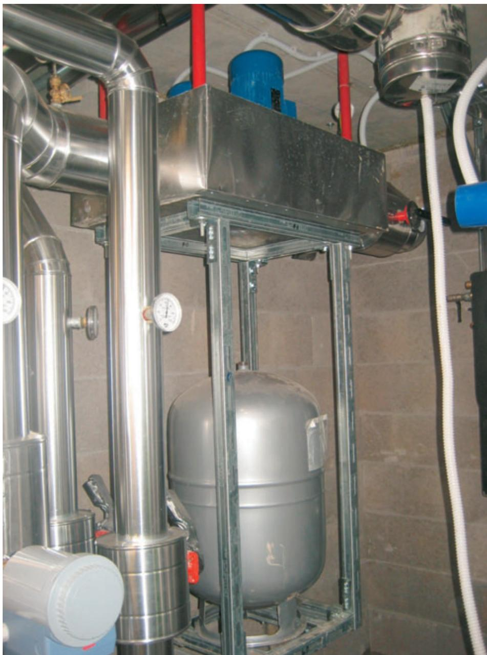
*Figura 50 – Apparecchiature della sottocentrale sospese a soffitto dell' autorimessa "RTI Eschilo".*
