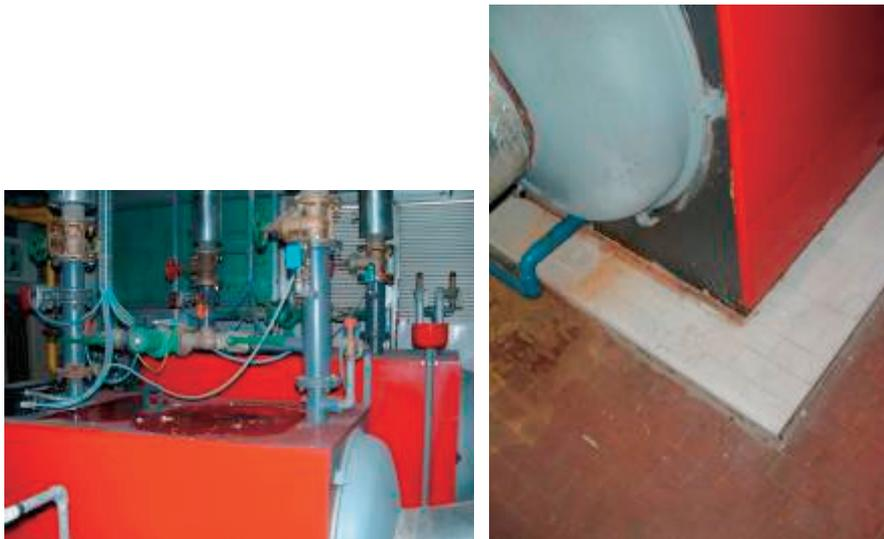
*Figura 12 – Perdita d'acqua dalle tubazioni sopra la caldaia (foto a sinistra). Scorrimento della caldaia sul basamento e distacco della condotta dei fumi dalla caldaia (foto a destra). Centro operativo delle Poste Italiane L'Aquila. Terremoto de L'Aquila 2009.*
