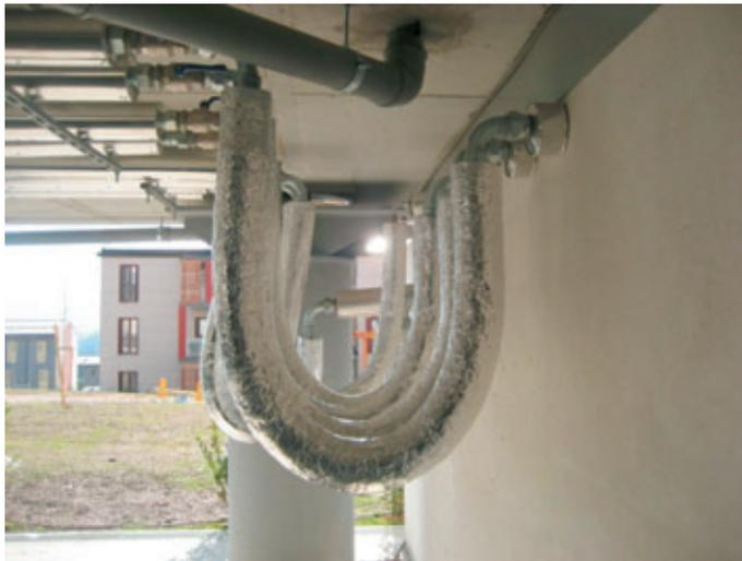
*Figura 40 – Giunti flessibili in acciaio per l'impianto centralizzato.*
