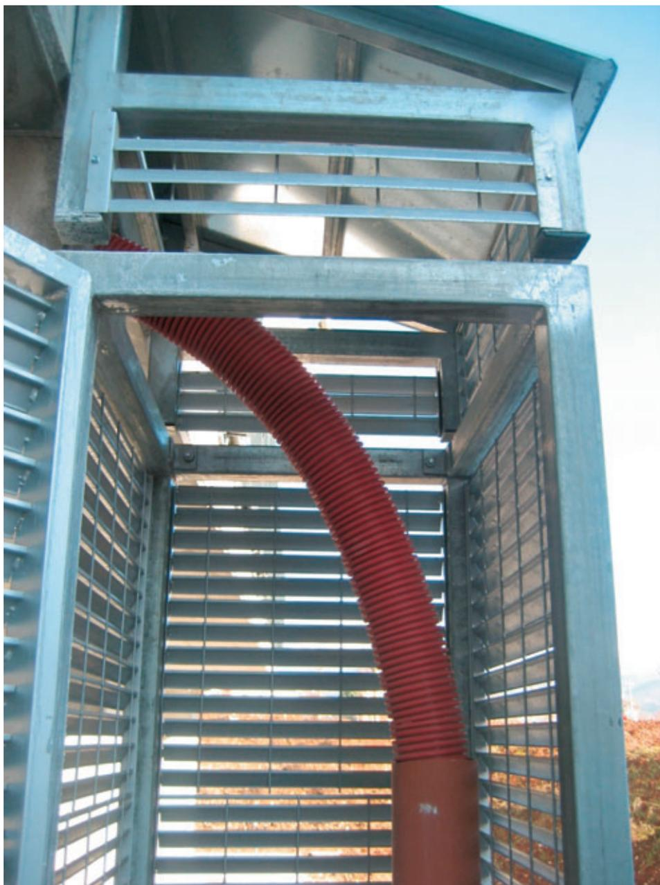
*Figura 21 – Giunto sismico per il collegamento ENEL.*
