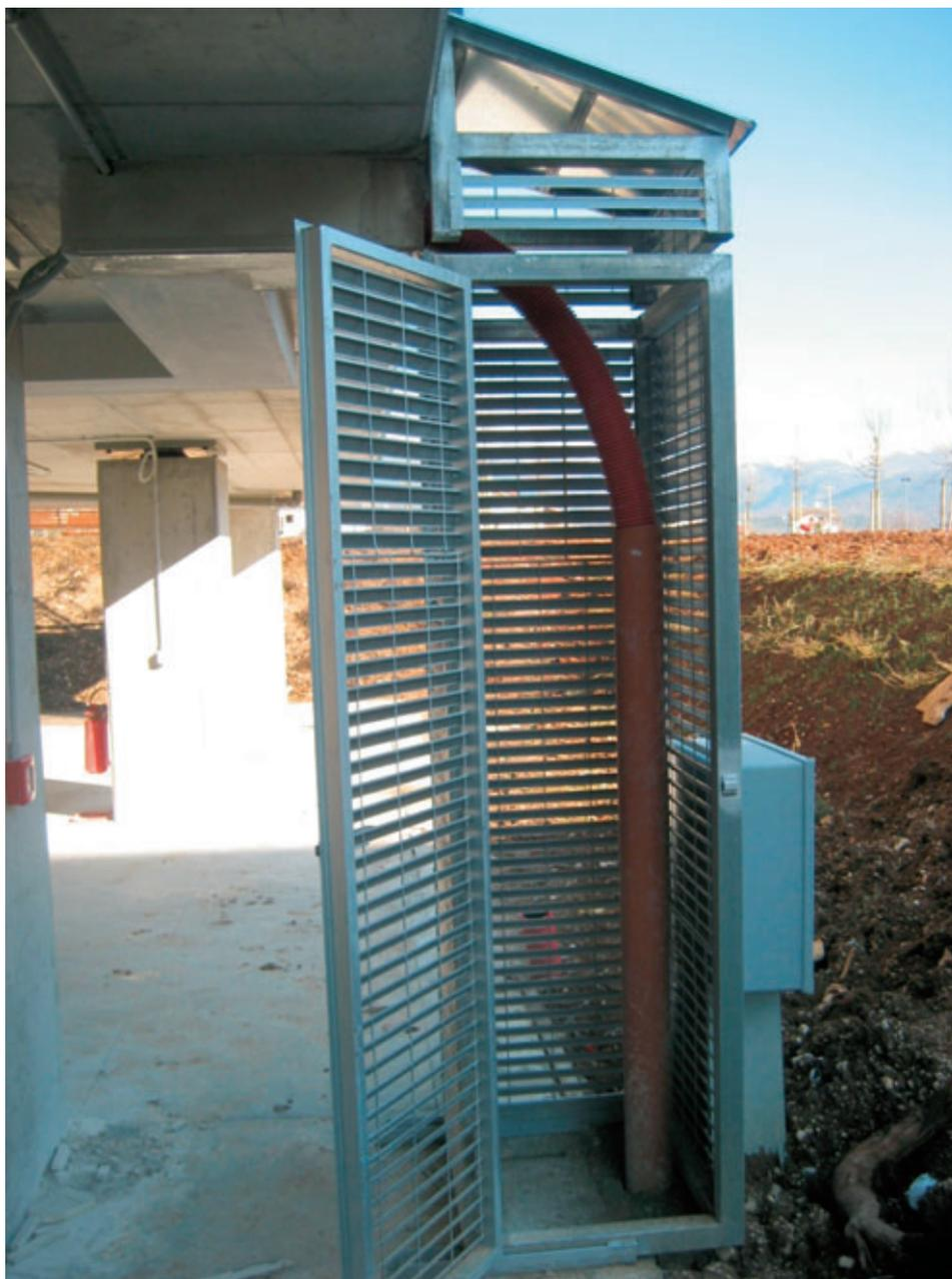
*Figura 20 – Giunto sismico per il collegamento ENEL.*
