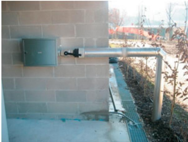
*Figura 13 – Isolamento termico acquedotto.*
