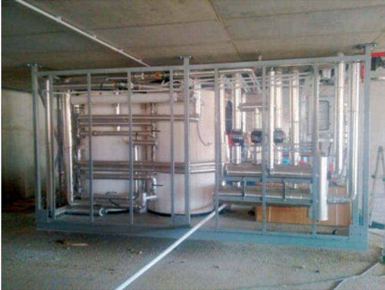
Figura 46 – Sottocentrale sospesa e solidale con la piastra antisismica “Cosbau SpA”.
