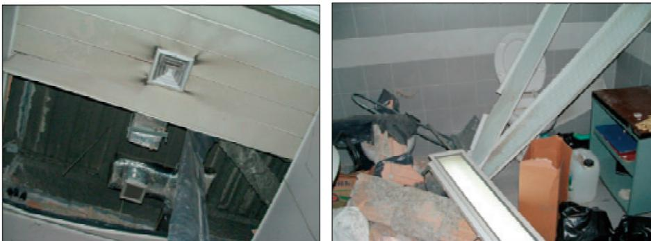
*Figura 5 – Effetti dell'interazione tra componenti impiantistici ed altri componenti costruttivi non strutturali. Vista del soffitto (foto a destra). Elementi di controsoffittatura, di partizioni in mattoni forati e lampade crollati (foto a sinistra). Centro operativo delle Poste Italiane L'Aquila. Terremoto de L'Aquila 2009.*
