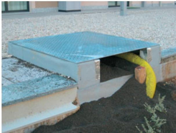
*Figura 28 – Giunto sismico per il collegamento ENEL GAS.*
