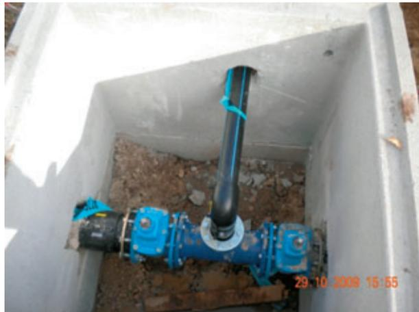
Figura 10 – Pozzetto acquedotto, foto.
