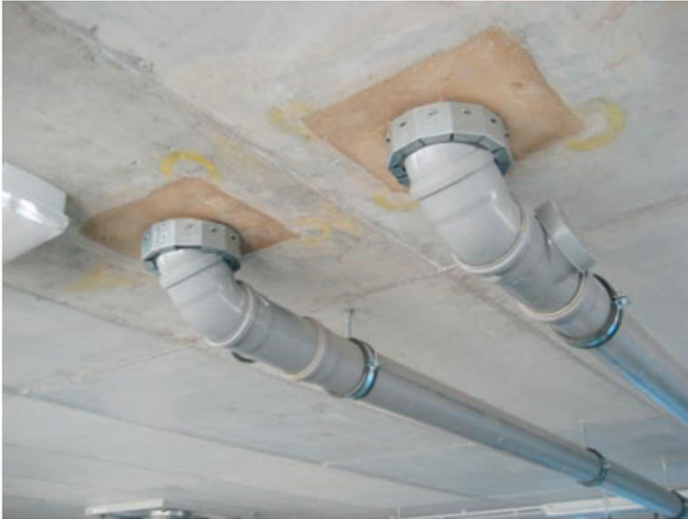
Figura 37 – Collari antincendio per tubazione di scarico passanti a soffitto del piano autorimessa.
