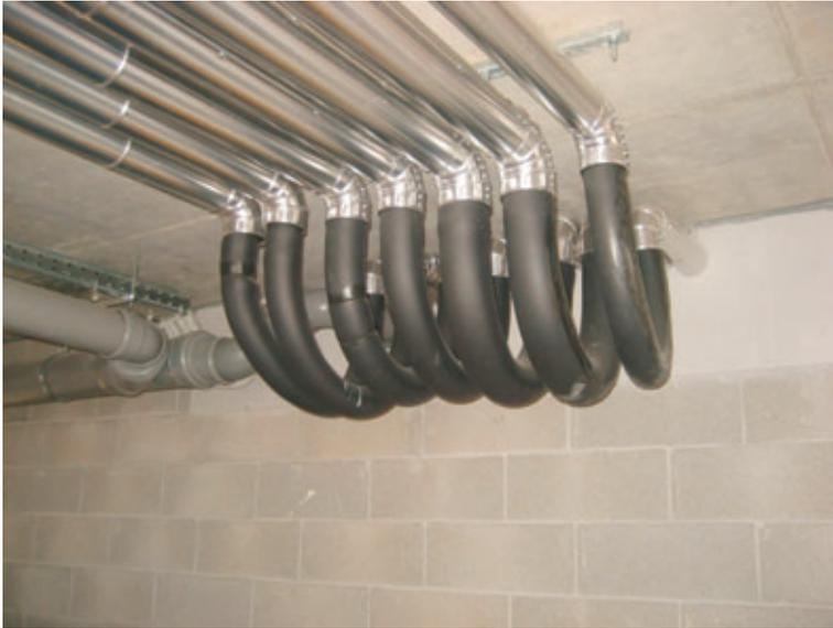
*Figura 39 – Giunti flessibili in acciaio per l'impianto centralizzato.*
