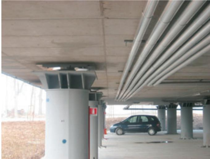
*Figura 41 – Distanza di sicurezza tra i tubi a soffitto ed i pilastri.*
