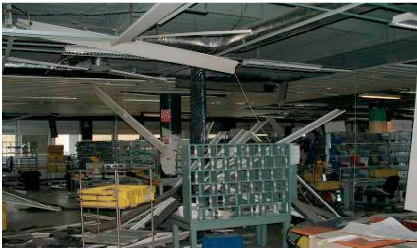
*Figura 1 – Danni agli elementi non strutturali al Centro Operativo delle Poste Italiane a seguito del terremoto de L'Aquila 2009.*
