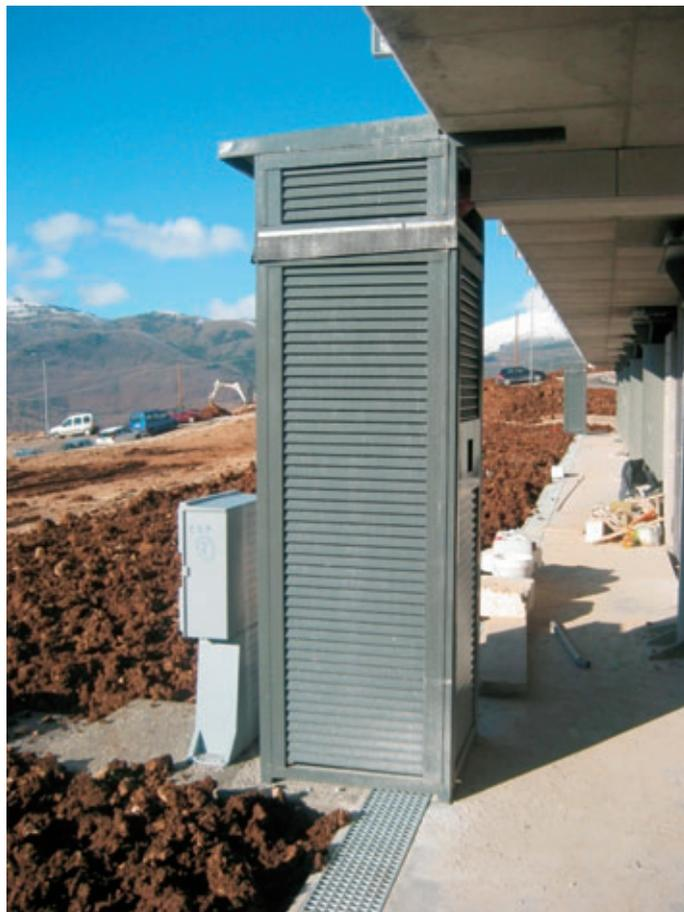
*Figura 23 – Protezione in orso grill del collegamento ENEL.*
