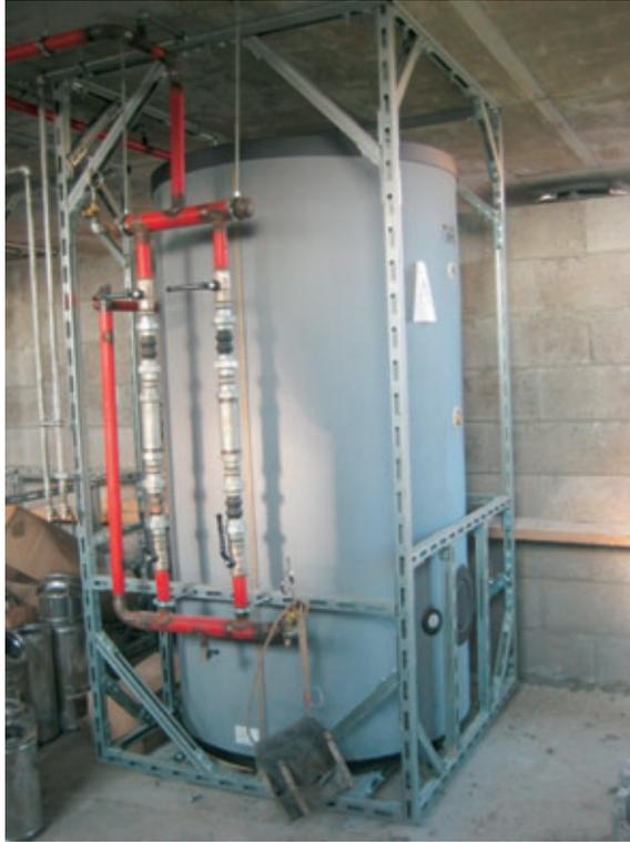
*Figura 49 – Apparecchiature della sottocentrale sospese a soffitto dell'autorimessa "RTI Eschilo".*
