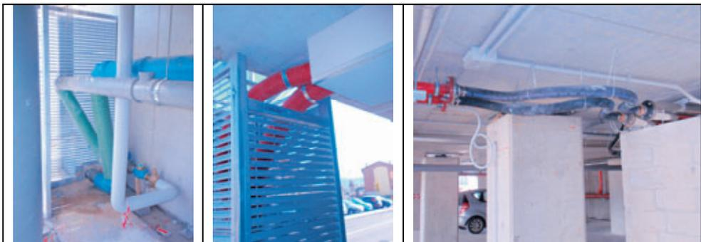
Fig. 6 – Esempi di connessioni impiantistiche flessibili negli edifici con isolamento sismico del Progetto C.A.S.E. a L'Aquila, all'interfaccia tra parti isolate e non isolate.
