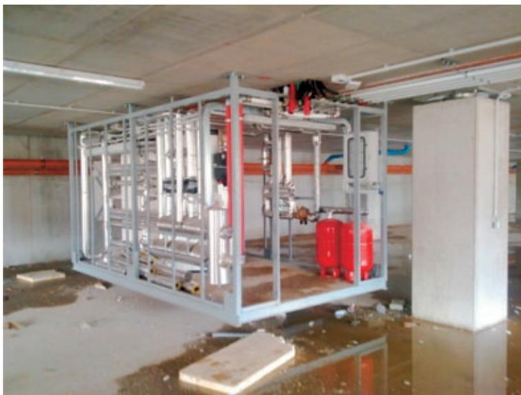
*Figura 44 – Sottocentrale sospesa e solidale con la piastra antisismica “Cosbau SpA”.*
