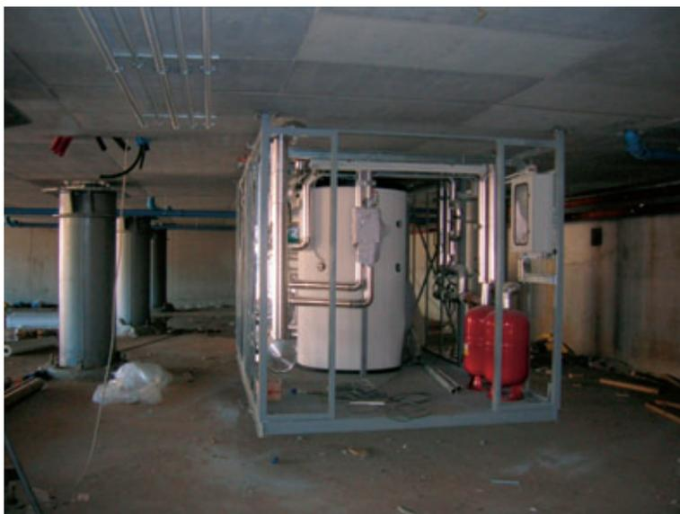
*Figura 45 – Sottocentrale sospesa e solidale con la piastra antisismica “Cosbau SpA”.*
