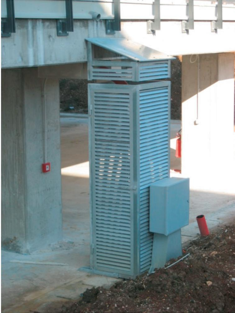
*Figura 18 – Giunto sismico per il collegamento ENEL.*
