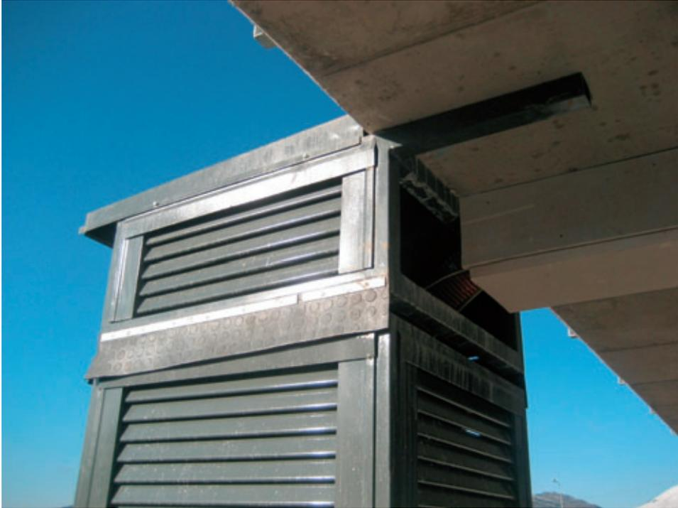
*Figura 24 – Giunto sismico per il collegamento ENEL.*
