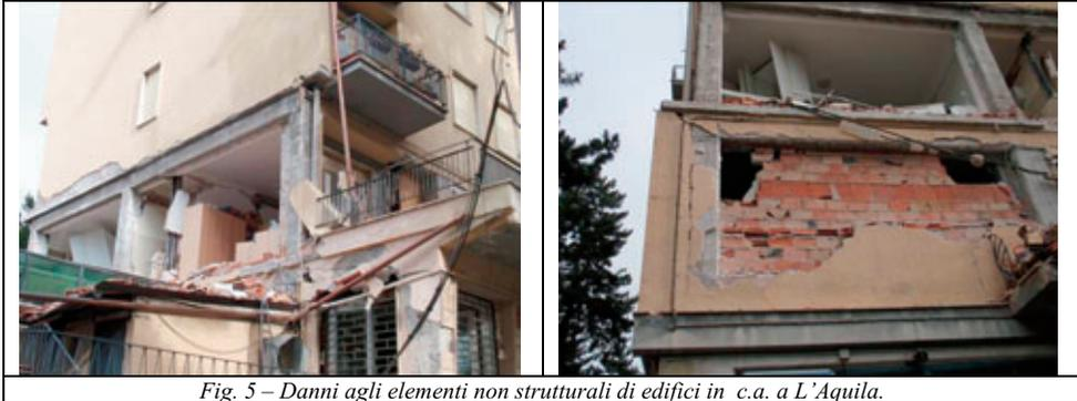
Fig. 5 – Danni agli elementi non strutturali di edifici in c.a. a L'Aquila.
