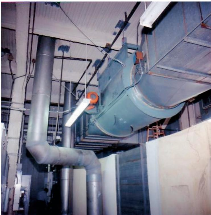
Figura 8 – Sospensione antisismica di ventilatore assiale
